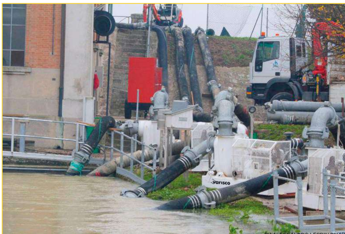
Drenaggio di zona allagata Assèchement de zone inondée Drenaje de lugar inundado
